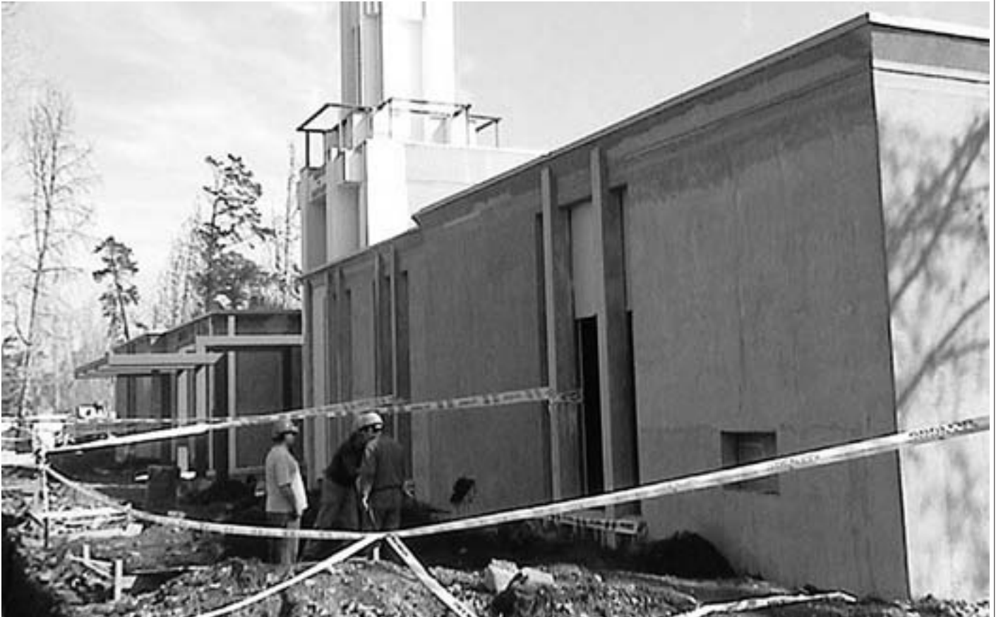
Santiagon temppelin laaja peruskorjaus Chilessä saatiin valmiiksi ennen temppelin uudelleenvihkimistä helmikuussa.
