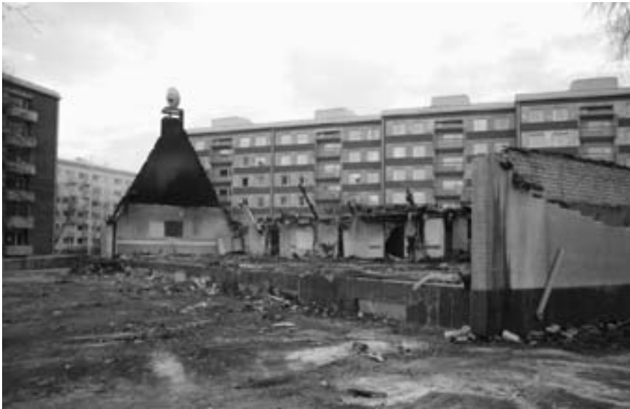
Palossa tuhoutunut Tampereen seurakuntakeskus.
