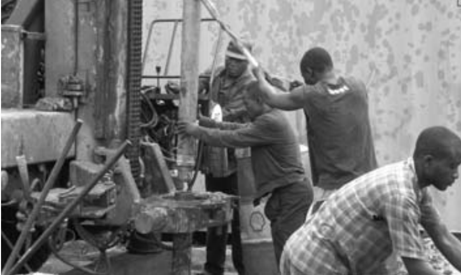
Paikalliset työntekijät poraavat raskaalla kalustolla uutta kaivoa osana kirkon ja Dikembe Mutombon säätiön yhteistyötä.
